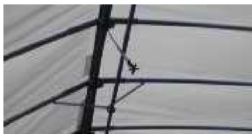
画像 1-4 ハウス上部に取り付けられたドライミストのノズル
