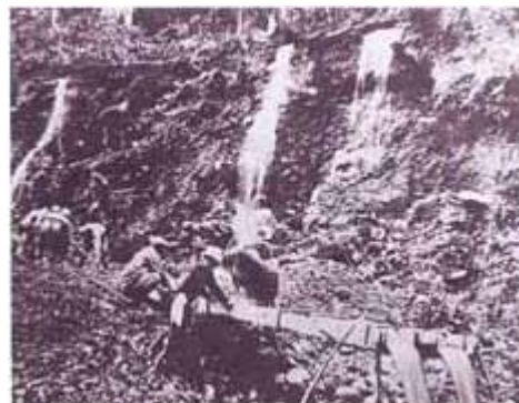
図3 中頓別ベーチャン川砂金堀の状況
