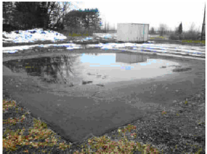
画像 4-6 雪山下の舗装
