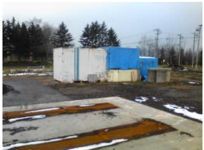
画像 4-7 保存実験用コンテナと トラフを設置した新たな舗装スペース
