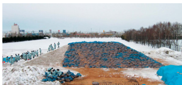
画像 4-1 被覆作業の様子
