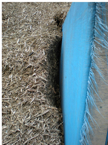
図-10 出入口部分に生じた隙間
