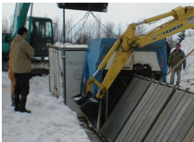
図-4 コンテナと三角通路の接続部分
