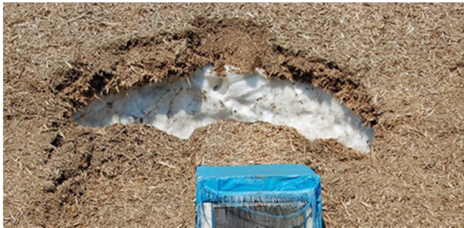
図-13 出入口の上部に生じた崩落（5月）
