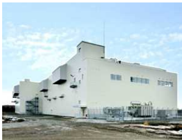
図1 南早来変電所に設置された蓄電池建屋
