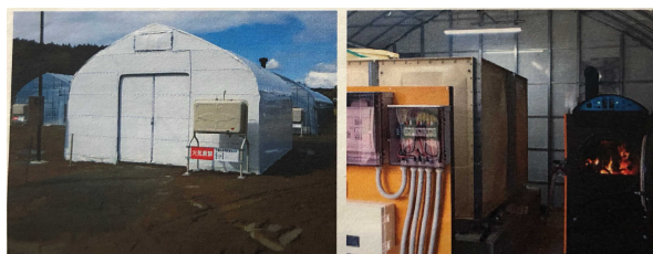
図 5 ボイラーハウス外観とハウス内
