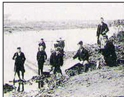
図 3 夕張川木詰の切り替え工事による新川造成(1889 年)
