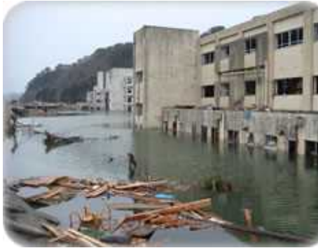
図 3-3 津波によって浸水した鶴住居小学校(手前)と釜石東中学校(奥)
